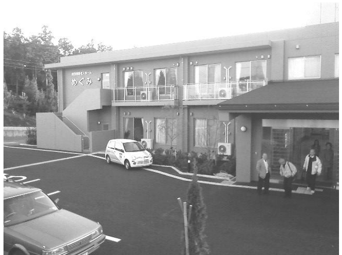
1月完成した「めぐみ」(正面玄関前)
